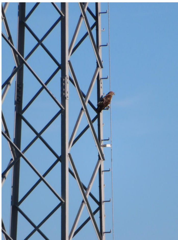
Figuur 8.1. Buizerd op een hoogspanningsmast op de 380 kV-verbinding Diemen-Ens, op zoek naar een prooi.
